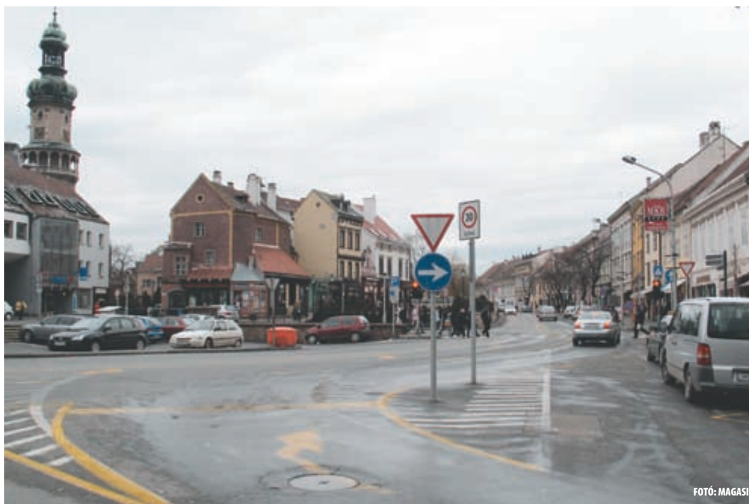
A VÁRKERÜLETI CSATORNASZAKASZT EGY SAJÁTOS TECHNOLÓGIÁVAL, ÚGYNEVEZETT FÖLD ALATTI SAJTOLÁSSAL ÉPÍTIK MEG.
